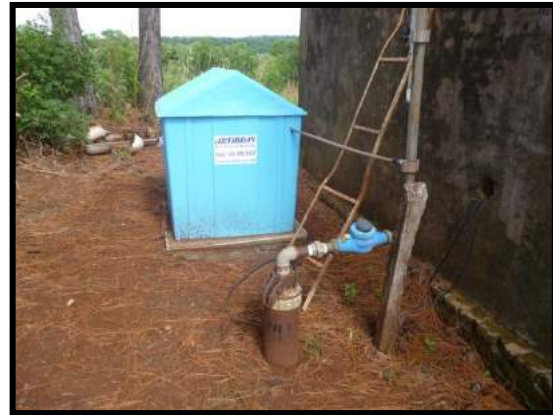
Figura 13: Poços tubulares utilizados no abastecimento urbano.
